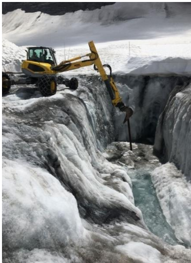
Abb. 5. Plaine Morte-Gletscher, Auslauf Faverge-See Bohrung zur Öffnung eines Kanals 2019, Artikel Simmentalzeitung 07.02.2020.
